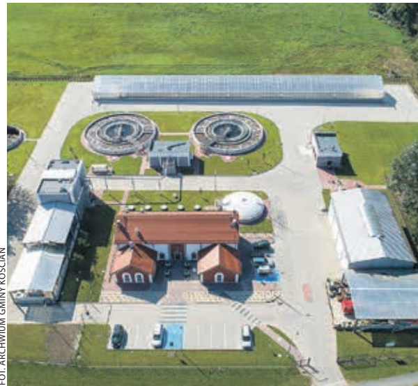
Rozbudowana oczyszczalnia w Racocie „z lotu ptaka”.
