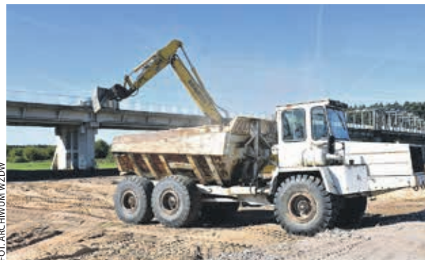
Od kilku tygodni na budowie mostu przez Wartę w Rogalinku pracuje już ciężki sprzęt.
