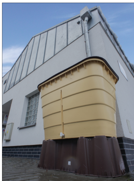
Zbiornik naziemny przy Budynku Tradycji w Godzieszach Wielkich, zrealizowany w ramach zadania pn. Wykorzystanie wody opadowej w celu nawadniania zieleni przy Budynku Tradycji w Godzieszach Wielkich.
